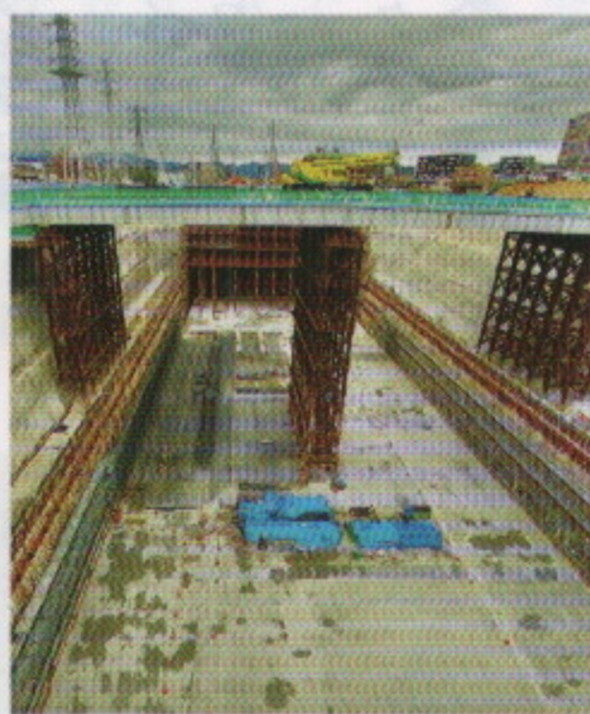
駅工事の様子
